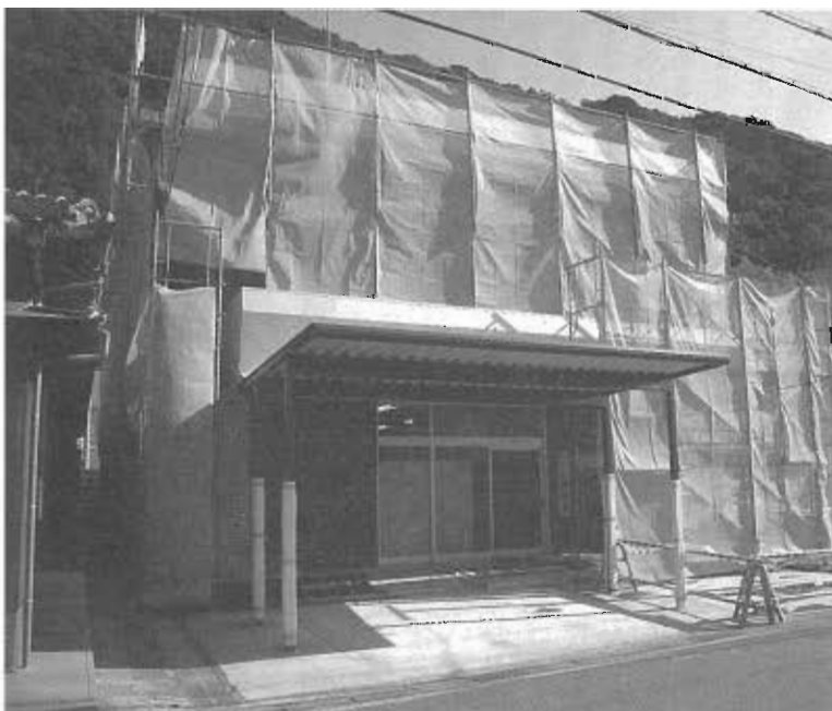
耐震工事中のすさみ消防署
