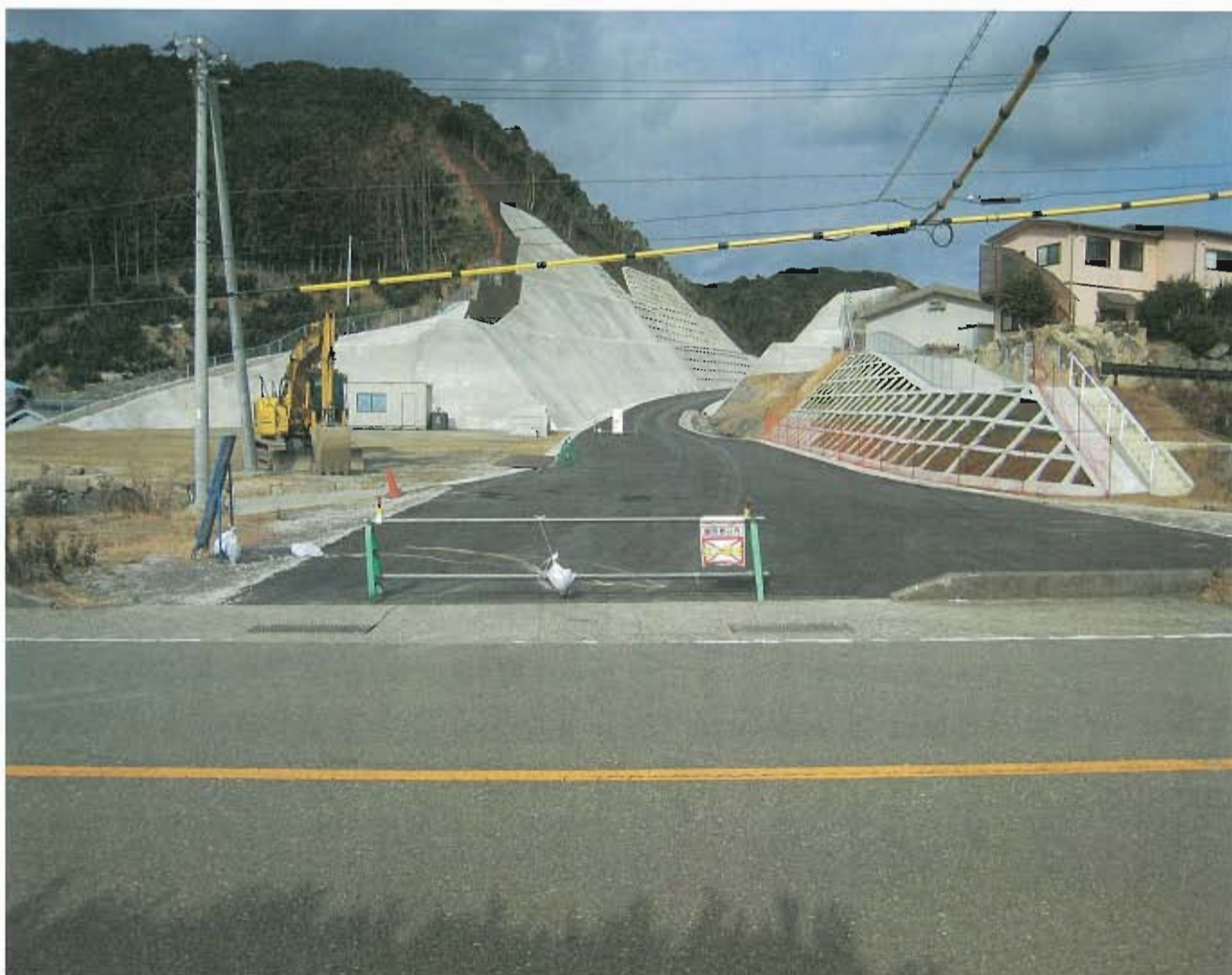
高速道路への取り付け道路として建設中の江住バイパス
