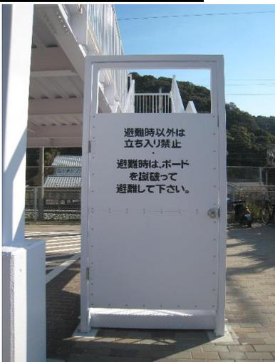
既存のタワーに2箇所、新タワーに2箇所設置しており、扉は施錠していますが、非常時には扉のパネル(珪酸カルシウム板)を破って進入して下さい。(既存タワーから通路を通過して、新タワーの階段に連結しています。)
